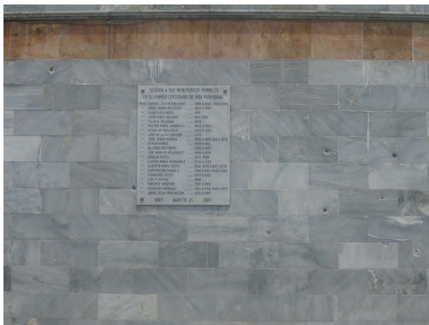
Fotografía N° 17. Fachada del templo parroquial de Segovia con los impactos de bala de la masacre del 11 de noviembre de 1988. Fotógrafo: Ronald Villamil Carvajal / CNMH
